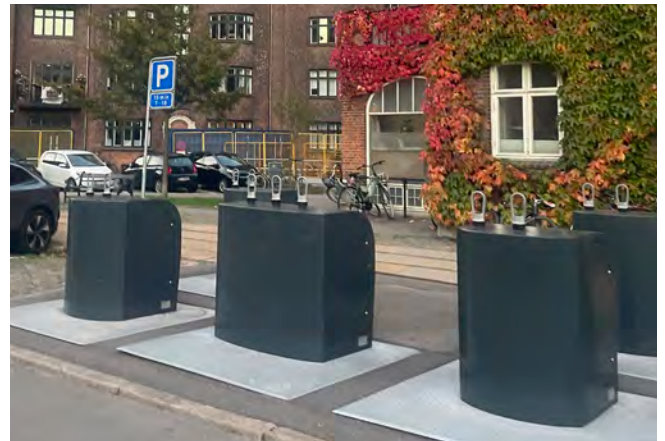
Foto af nedgravede affaldsløsning
