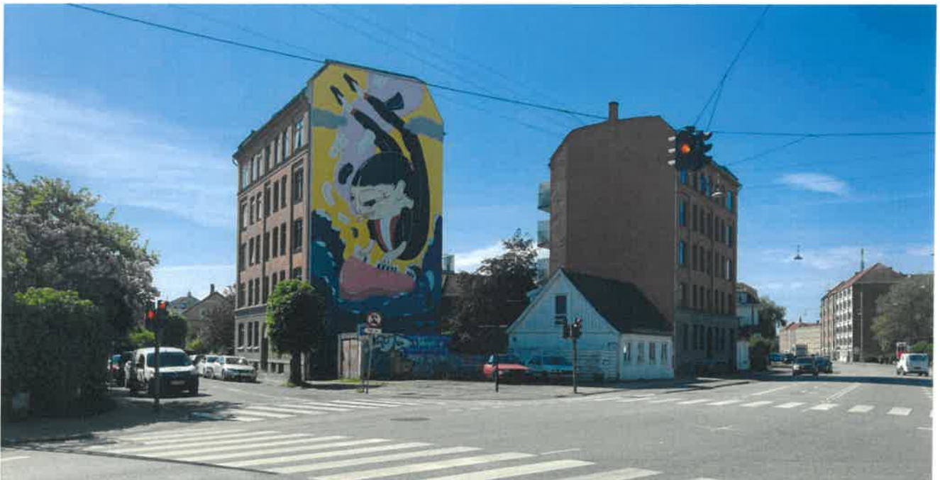
Vejkrydset ved Engelsvej 21, hvor Torben Oxes Allé fører ned til Eberts Villaby. Fra denne vinkel ses også det grønne gårdmiljø der allerede er eksisterende i gården bag til Engelsvej 21. Foto: Over Byen Arkitekter.
